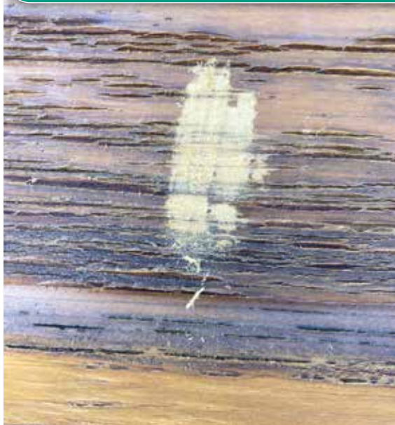
Glacis filmogène avec pénétration d'humidité = écailage ou moisissure
