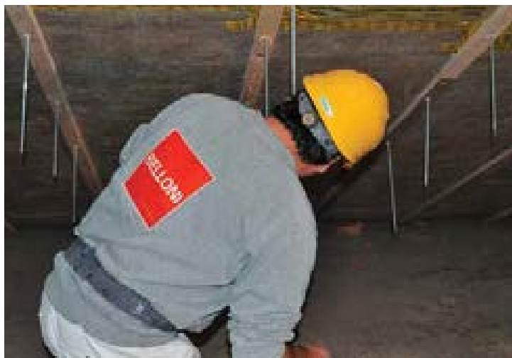
Pose des tiges M8 pour suspension des faux-plafonds
