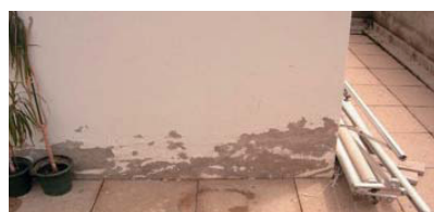
Afin d'éviter le décollement de peinture, le bitume doit être appliqué 5 cm minimum en dessus du dallage.
