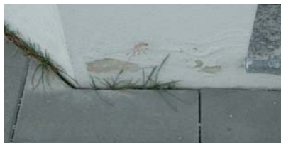
Décollement de crépi suite à une négligence lors de l'application du bitume.
