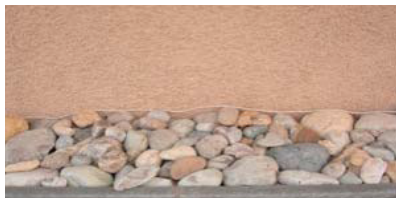
Si possible mettre des granulats contre la façade et non la terre
